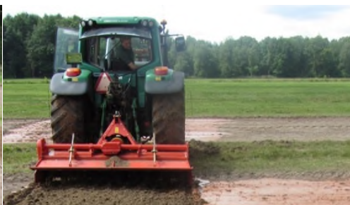
F. FREZEN VAN VLAK MET IJZERSLIB
